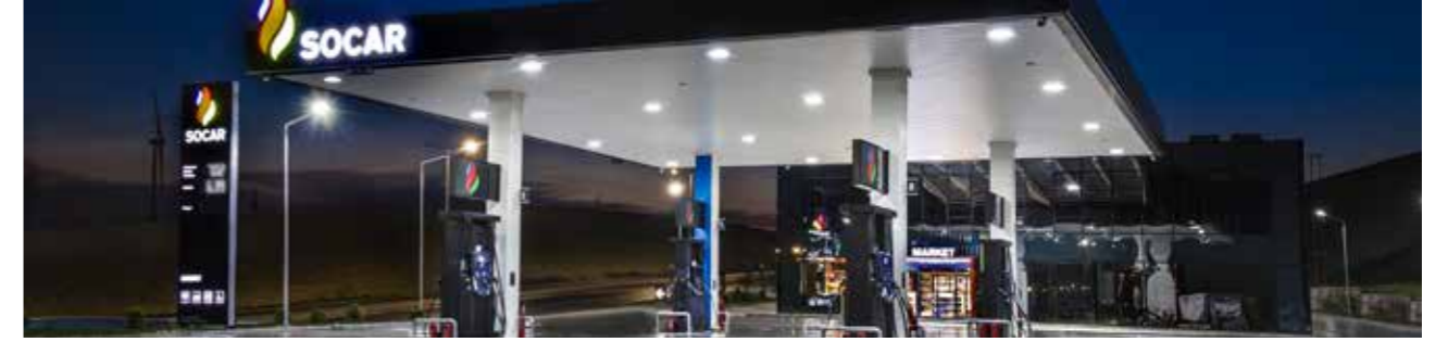
SOCAR Dağıtım, İstanbul Havalimanı'nda 9 yeni istasyon inşaatına başladı.
